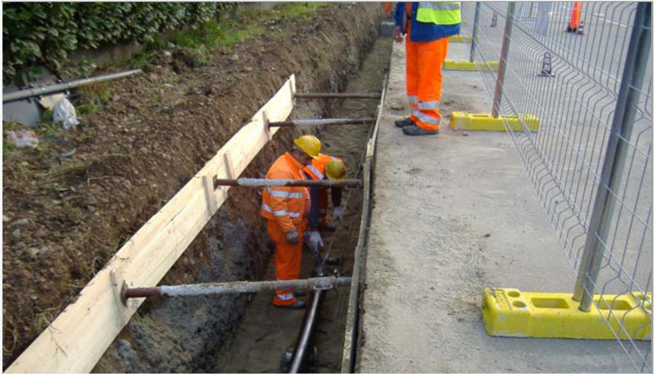
Pose d'un câble 400 kV en Italie le long d'une route départementale. Les techniques de pose des câbles THT évoluent assez rapidement au fur et à mesure que l'expérience augmente auprès des gestionnaires de réseaux. Les installations récentes pour des capacités de transport non excessives et dans des zones non densément peuplées ont permis une simplification très importante des techniques de pose, qui devient de plus en plus semblable à celle des câbles HT.
